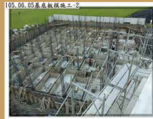
105.06.05基礎板模施工-2
